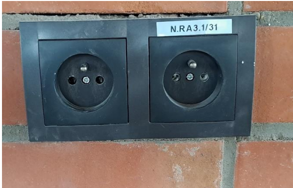
Zdj. 15 Przykładowe gniazdo 1-fazowe w Lokalu.
