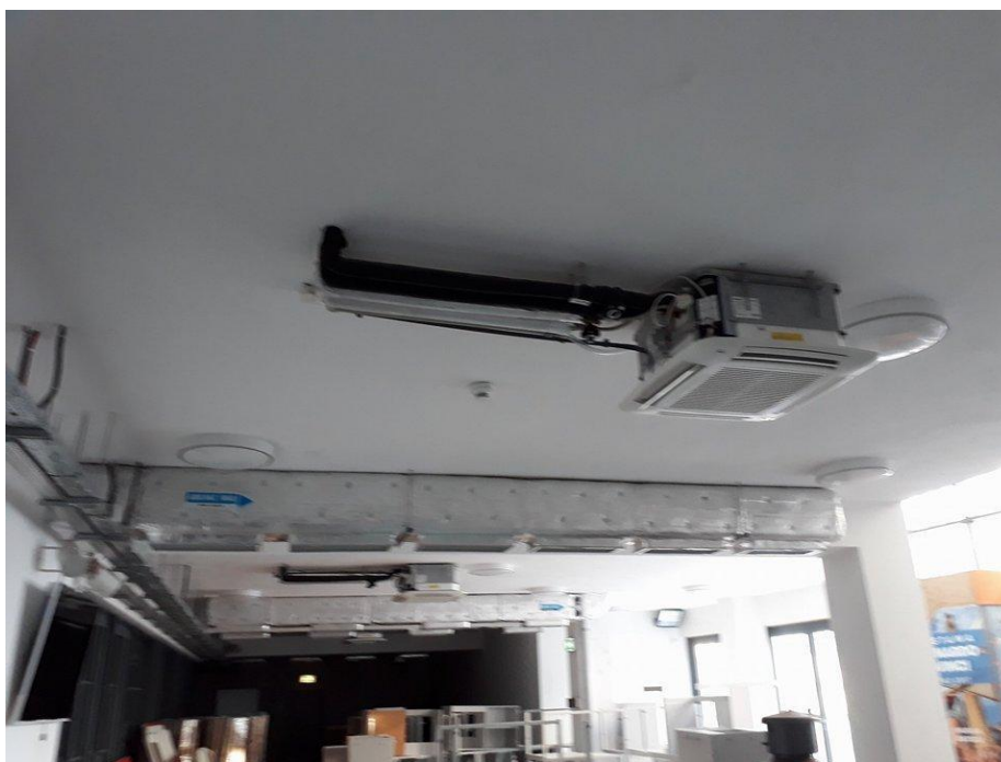
Zdj. 5. Strop nad poziomem parteru
