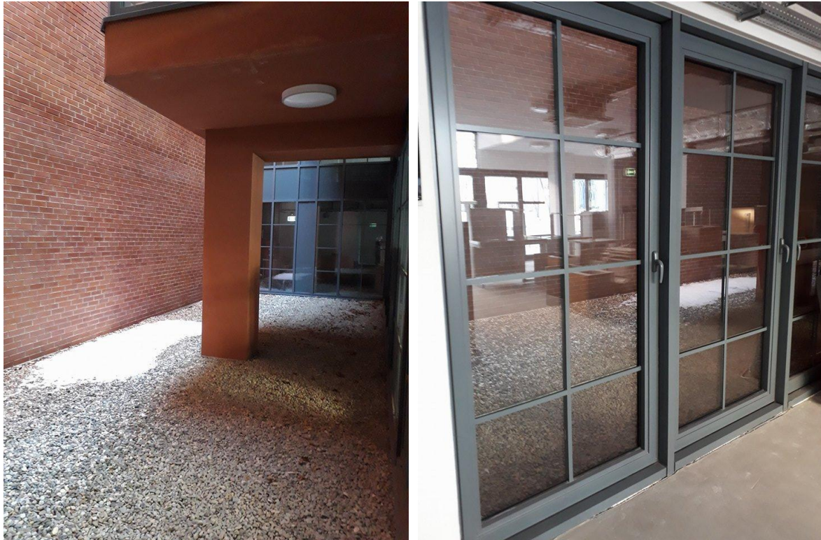
Zdj. 10. Patio, drzwi do patio
