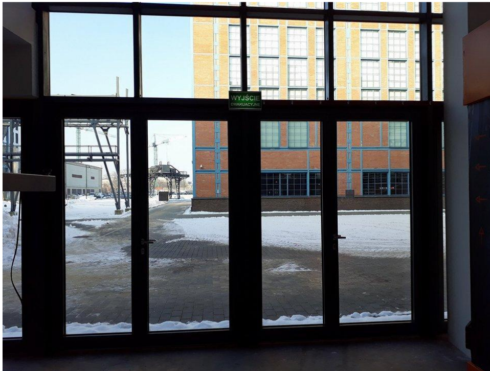
Zdj. 13. Drzwi zewnętrzne w ścianie kurtynowej północnej prowadzące na teren zewnętrzny EC1
