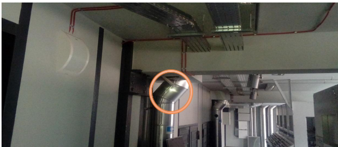
Zdj. 18 Rewizja sufitowa na poz. 1 w pomieszczeniu nr 1.9.
