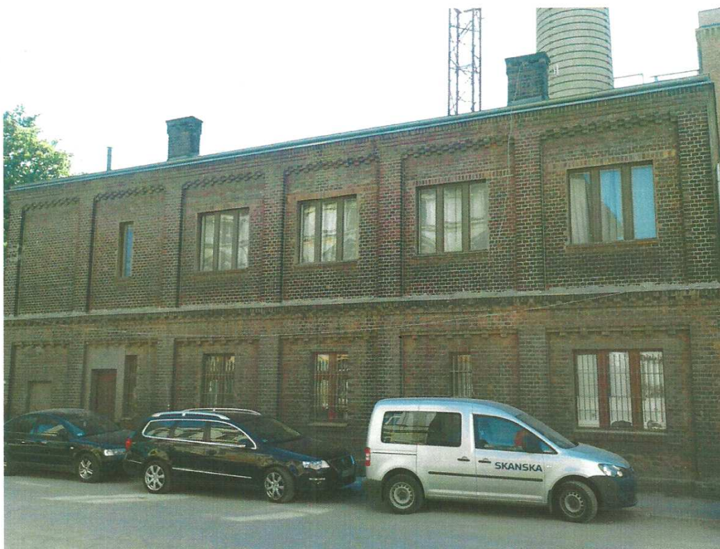
Łódź, ul. Targowa 1/3 Budynek nr 12 Elewacja wschodnia – stan istniejący z dnia 24.05.2012
